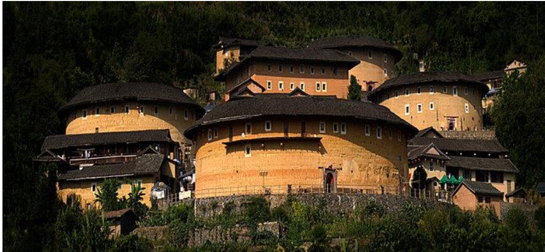
Erd-Rundbauten der Hakka in Yongding
